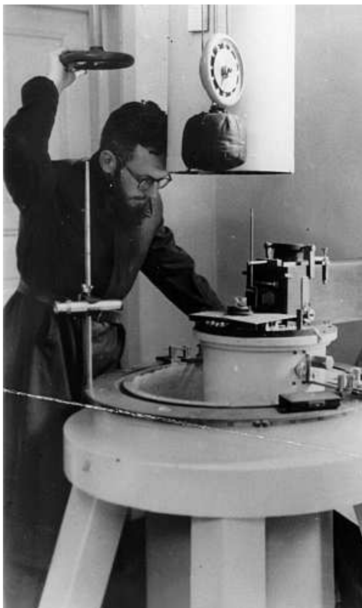
Figuur 13: C. de Jager bij de spectroheliograaf, 1944. De heliograafbuis kantelde om een draaipunt beneden in de kelder, zodat de ingangsspleet het zonsbeeld aftast. De Jager, toen nog zwartharig en met andere studenten ondergedoken op Zonneburg, verdraait de tweede coelostaatspiegel in azimut. Het touw met katrol en zandzak diende voor de elevatie-instelling met een worm en wormwiel die, met Minnaertse handbediening, te zien zijn in Figuur 12.
